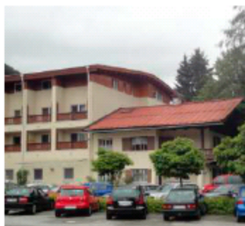
Das Therapiezentrum derzeit. Ein Teil des bestehenden Hauses wird abgerissen. Foto: Wittlinger
