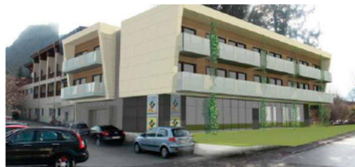
Ab Herbst entstehen u.a. 14 neue moderne Patientenzimmer. Investiert werden in Summe drei Mio. Euro. Foto: Wittlinger
